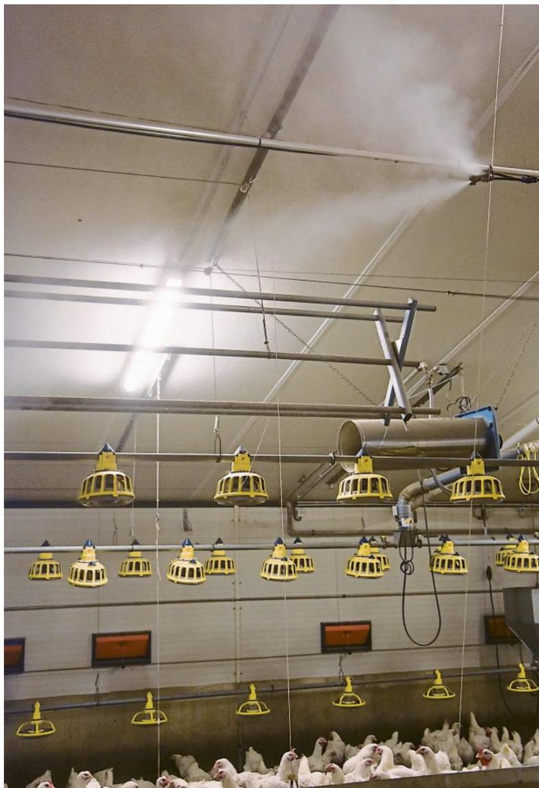
Im Stallvorraum (rechts) wird der Kräuterextrakt angesaugt und anschließend im Stall vernebelt.
