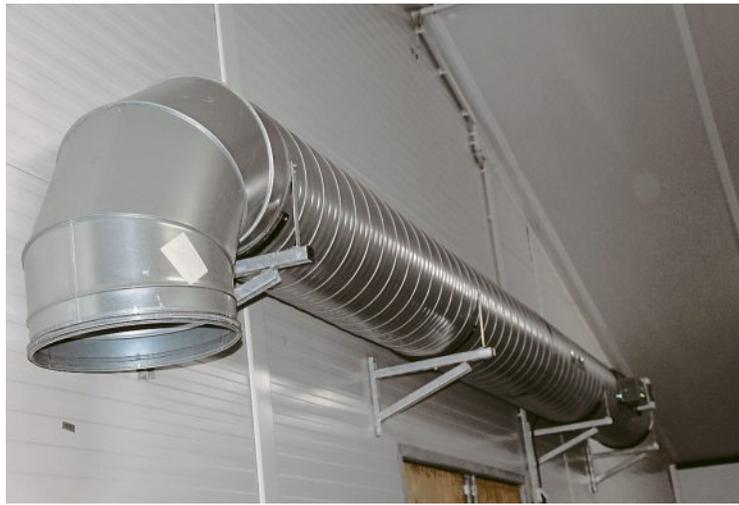
**Im Eierlager:** Auch hier setzt Hemker auf die Bekämpfung „schlechter“ Keime. Damit die zweimal in der Woche abgeholten Bruteier nach dem Legen nicht mit Keimen in Kontakt kommen, hat Jürgen Hemker eine trockene Luftdesinfektion (Foto) installiert. Sie tötet Keime durch Ozon und UV-Strahlen ab. Etwa vier- bis fünfmal in der Stunde wird die gesamte Luft des Eierlagers umgewälzt.
